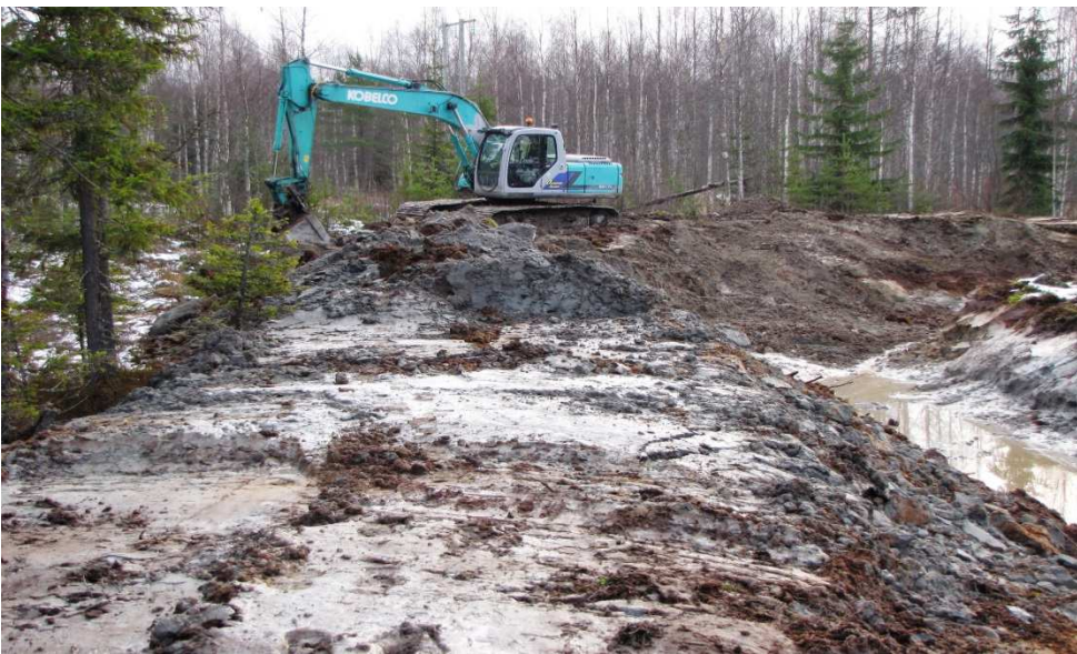
Patovallien rakentaminen vaati mittavat maansiirtotyöt. Kuva Reijo Kotilainen 6.11.2012
