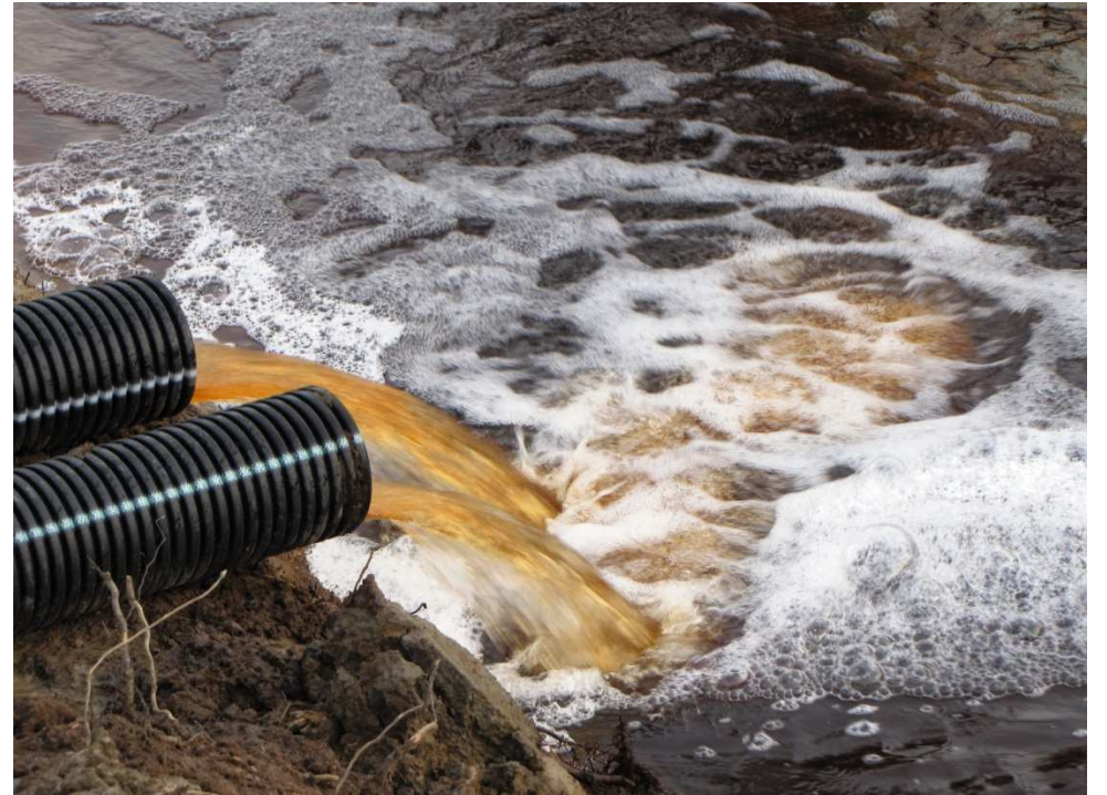
Kosteikon vedenpintaa voidaan säädellä ja kosteikko tyhjentää pohjapatoon asennettujen putkien avulla. Kuva Reijo Kotilainen 6.11.2012.
