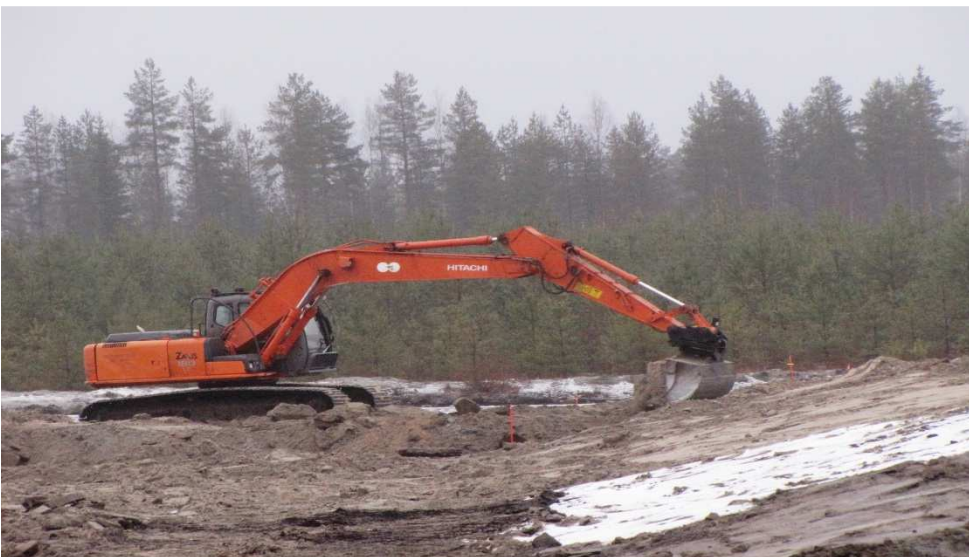
Patovallien rakentaminen vaati mittavat maansiirtotyöt. Kuva Reijo Kotilainen 26.11.2014
