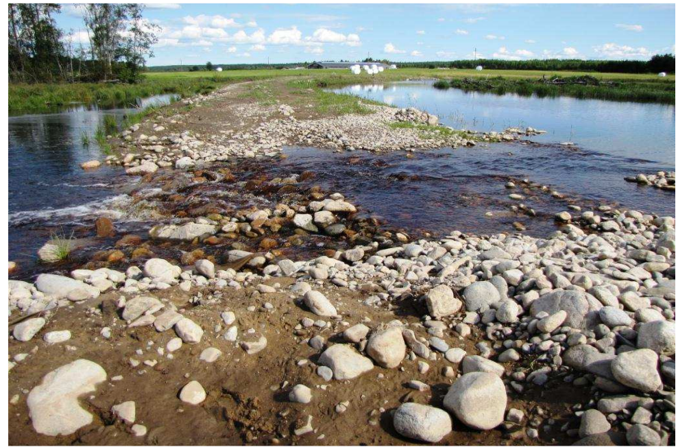
Kosteikon vedenpintaa säädelään pohjapadolla, mistä vesi ohjataan pintavalutus kentän kautta Lahnasen järveen. Kuva Reijo Kotilainen 15.8.2012.
