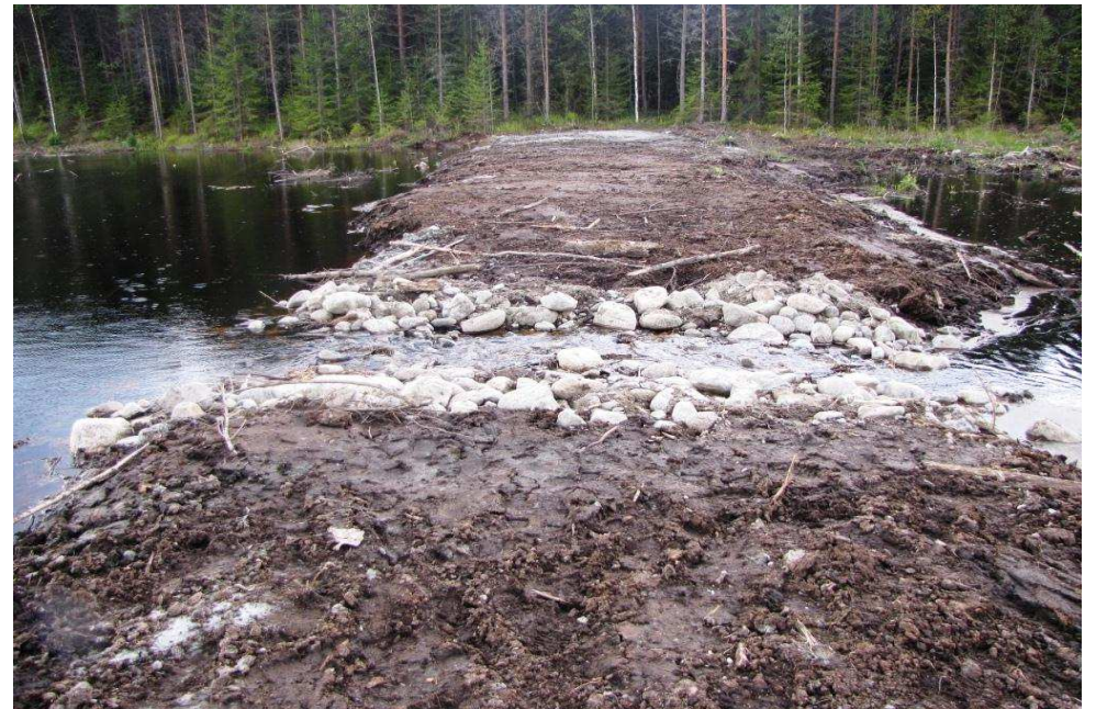
Kosteikossa on kolme patovallia. Vedenpinta on säädeltä pohjapadoilla kolmeen eri tasoon. Kuva Reijo Kotilainen 15.8.2012
