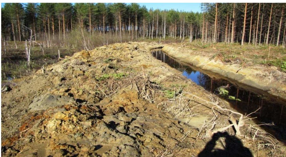
Kosteikkoon laskeva puro ohjattiin virtaamaan kosteikon takaosaan, näin varmistettiin valumavesien pidempi viipymä kosteikossa. Kuva Reijo Kotilainen 16.5.2013.
