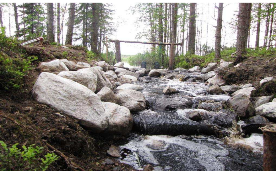
Kosteikon perustaminen padottamalla laskuoja on rakennuskustannuksiltaan edullisin tapa perustaa kosteikko. Kuva Reijo Kotilainen 26.6.2012.
