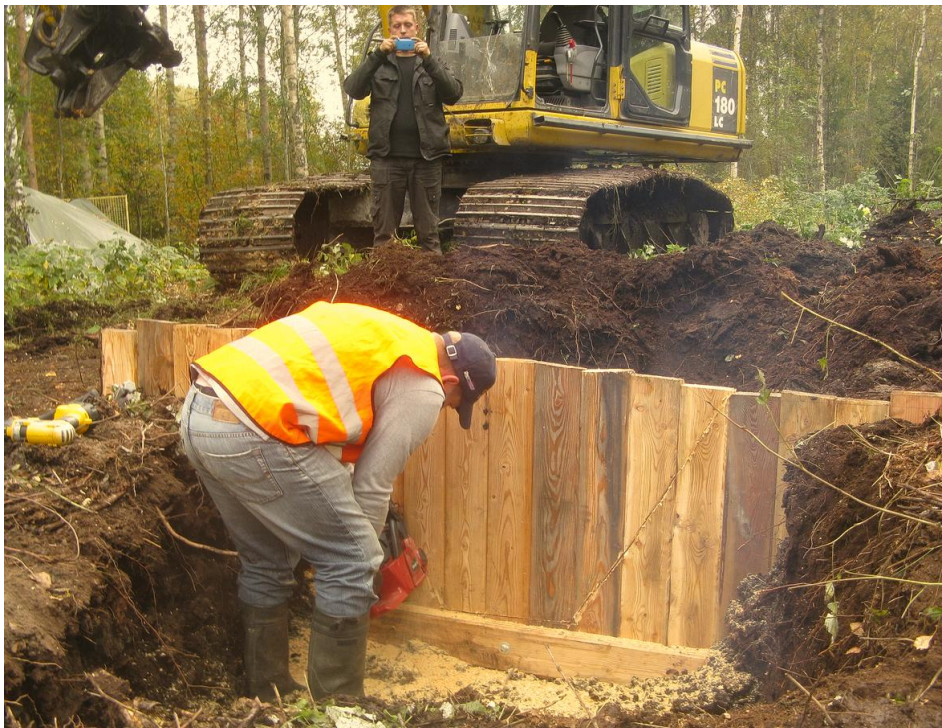
Lehtikuusilankuista rakennetut tiivisteseinät ja niissä olevat irrotettavat settilankut toimivat patolaitteina. Kuvat Juha Siekkinen 21.9.2013.
