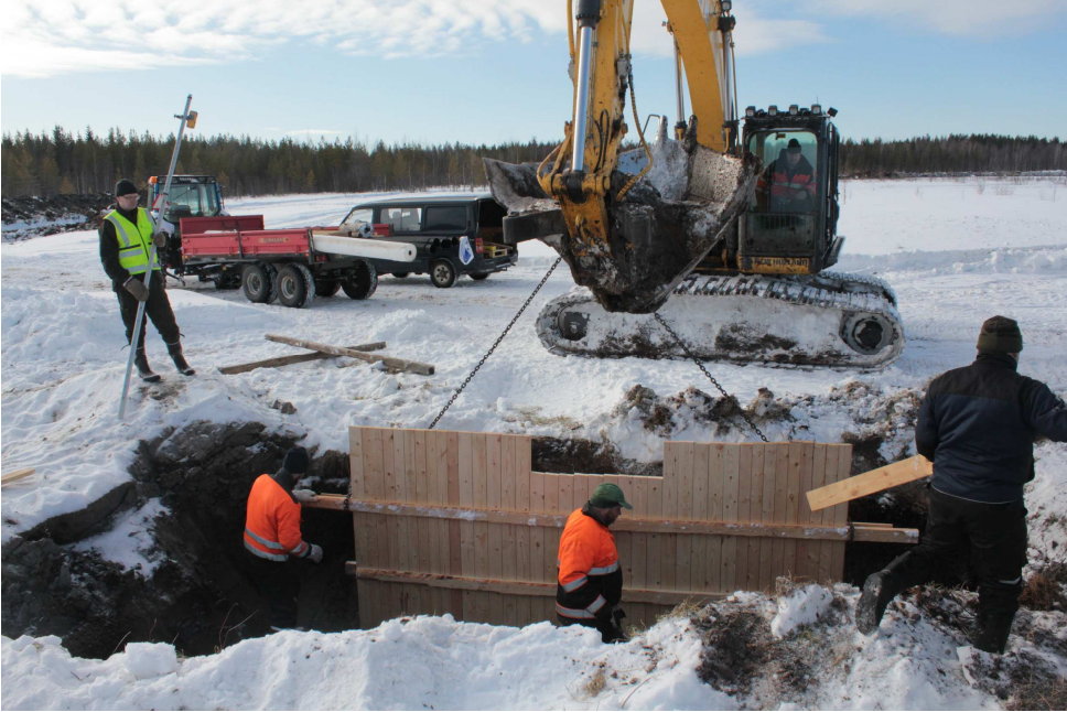
Lehtikuusilankuista rakennetut tiivisteseinät ja niissä olevat irrotettavat settilankut toimivat patolaitteina. Kuva Juha Siekkinen 15.3.2013.
