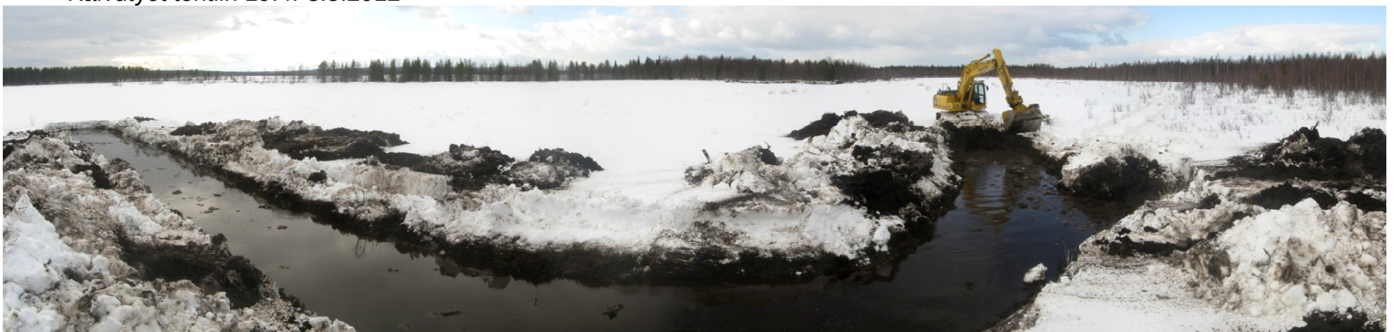
Avovesikanavat kaivettiin mutkitteleviksi ja leveydeltään vaihteleviksi. Kaivuumaat kasattiin ja maisemoitiin saariksi ja kosteikon itä- ja länsipuolille reunapenkereiksi. Kaivuutöiden aikana maaperä ei ollut jäässä, mutta Otto Veikanmaa pystyi kuljettamaan kaivinkonetta puolen metrin paksuisen lumipeitteen päällä. Kuva Juha Siekkinen 19.4.2012.
