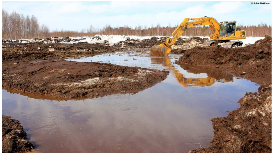
Kaivuumaat tasattiin ja maisemoitiin loivapiirteisiksi muodoiksi. Kuva Juha Siekkinen 26.4.2013.
