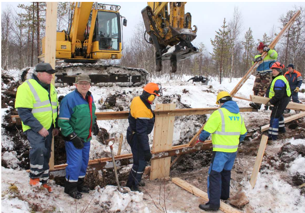
Taliojan pato rakennettiin kevythirsistä vanhan rantapenkan kohdalle. Työn tekivät Aapajärven Jahti ry:n jäsenet. Kuva Juha Siekkinen 26.2.2015.
