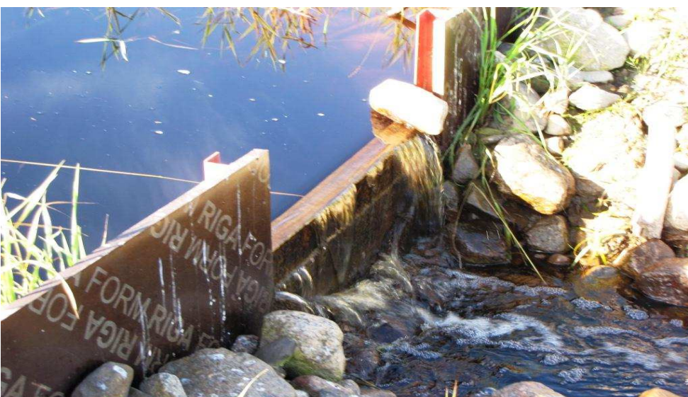
Kosteikon vedenpinnan korkeutta voidaan säädellä pohjapatoon asennetulla lankkupadolla. Kuva Reijo Kotilainen 16.8.2012.
