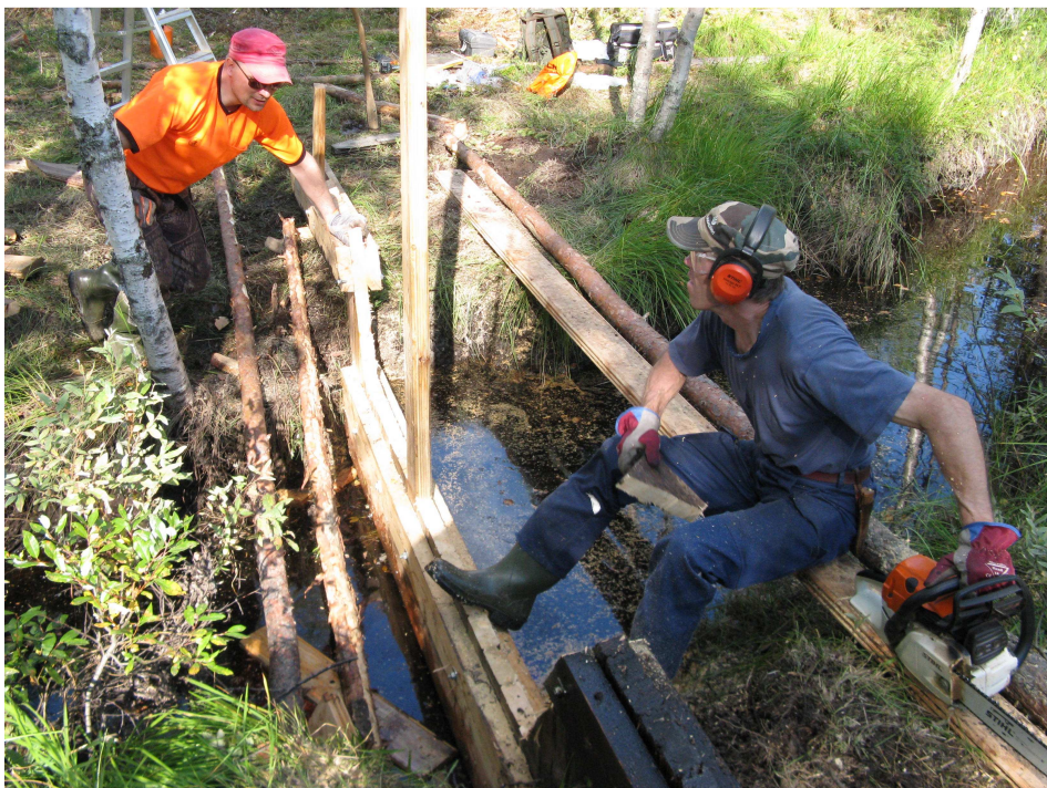
Latvajoen patoseinä rakennettiin lehtikuusesta. Kuvat Saara ja Juha Siekkinen 28.7. ja 25.8.2015.
