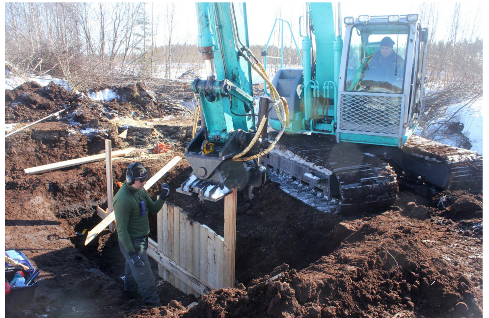
Pohjoisen kosteikon patolaitteena on kiviverhoiltu pohjapato, jossa on lehtikuusesta rakennettu tiivisteseinä. Tuomo Karjalainen (kaivinkoneessa) painoi lankut yksitellen maaperään, riistasuunnittelija Marko Paasimaa ohjaa työtä. Kuva J. Siekkinen 4.4.2013.
