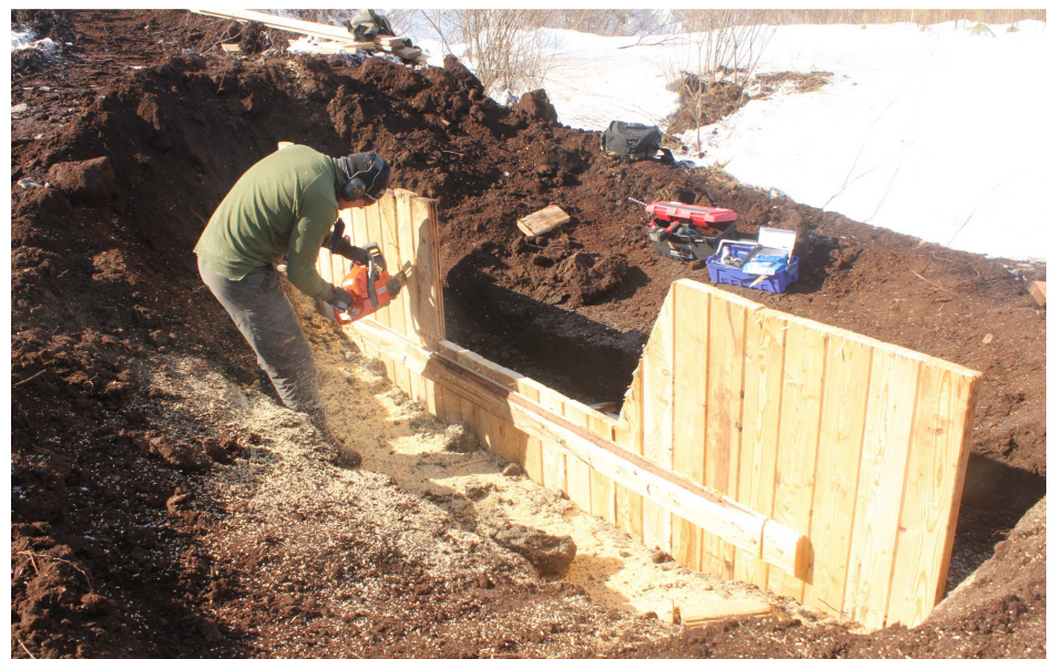
Lopuksi tiivisteseinä sahattiin oikeaan korkoon ja muotoon. Tämän jälkeen tehtiin kiviverhoilu tiivisteseinän molemmin puolin. Kuva J. Siekkinen 4.4.2013.
