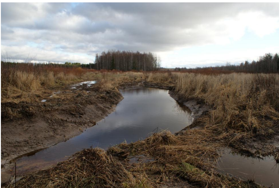
Syväneallas tyhjennetään muutaman vuoden välein siihen kertyneestä kiintoaineksesta. Kuva: Jouni Tolvanen, lokakuu 2013
