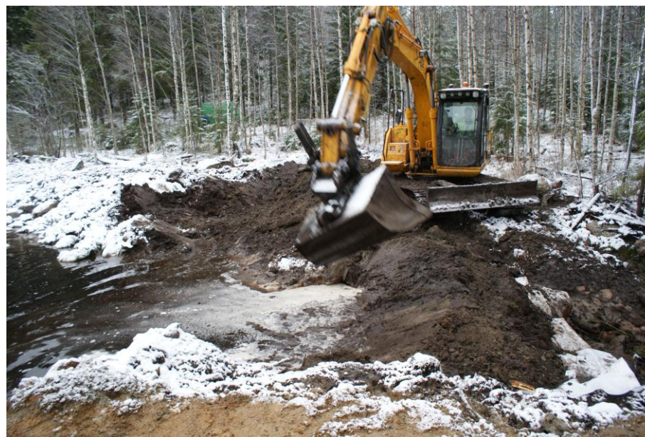
Padon kriittisin kohta, vanha uoma tiivistettiin korjauksen yhteydessä huolella. Kuva: Jouni Tolvanen, marraskuu 2012.
