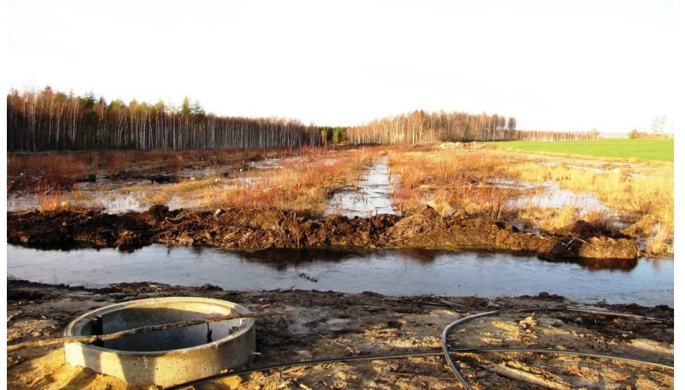
Yläpuolinen kosteikko ja munkkikaivo syksyllä 2013, jolloin vedenpinta oli lähellä padotuskorkeutta. Kuva Reijo Kotilainen 18.11.2013.
