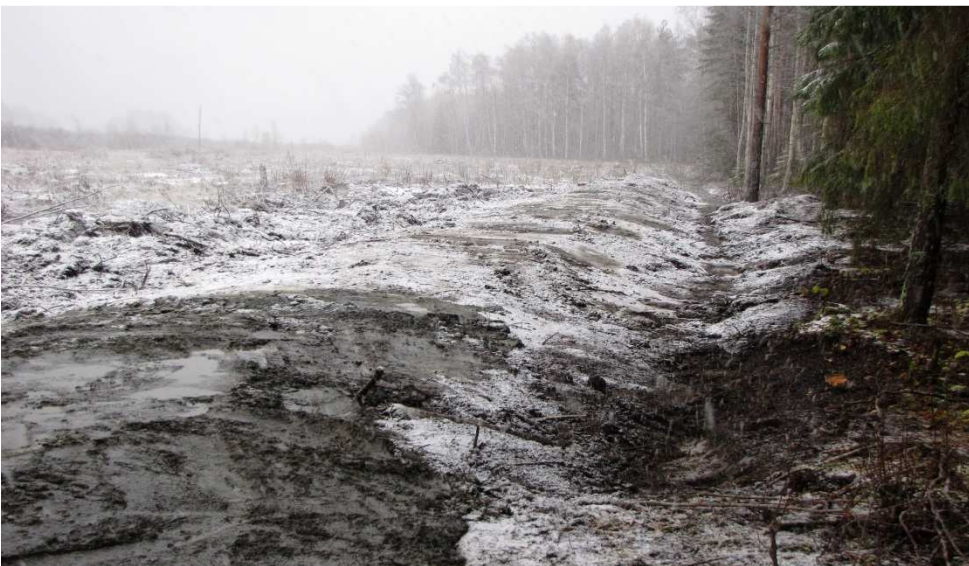
Kosteikon ympärille rakennettiin kaivumaista suojavallit. Kuva Reijo Kotilainen 18.10.2013.
