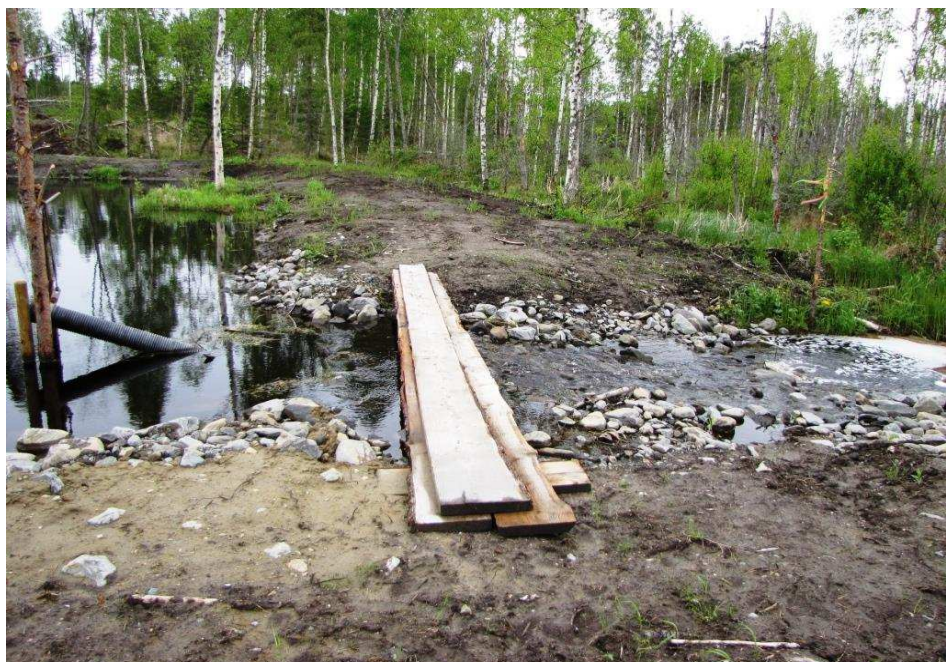
Kosteikon vedenpintaa nostettiin padottamalla laskevaa puroa. Kuva Reijo Kotilainen 28.5.2014
