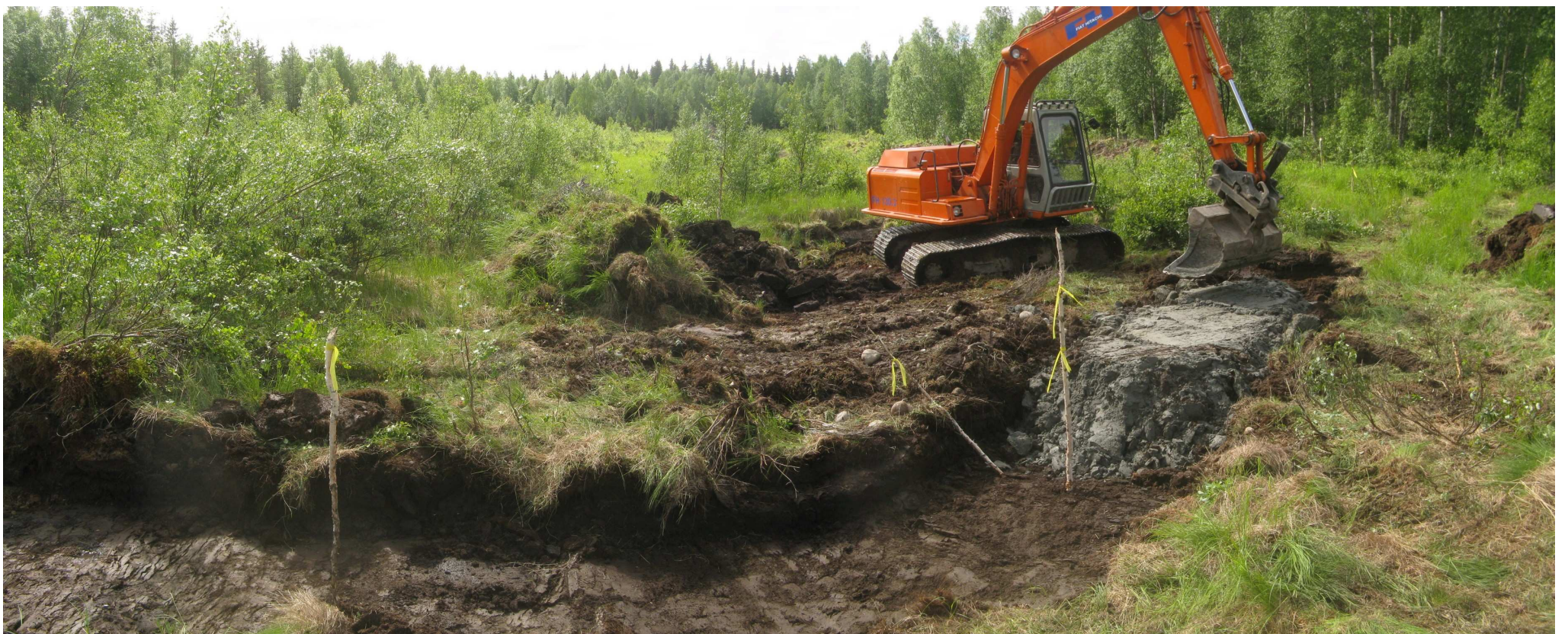
Konttilan kosteikon patopenkereen keskikohtaan tehtiin heikosti vettäläpäisevä saviydin. Juha Siekkinen 13.6.2013.
