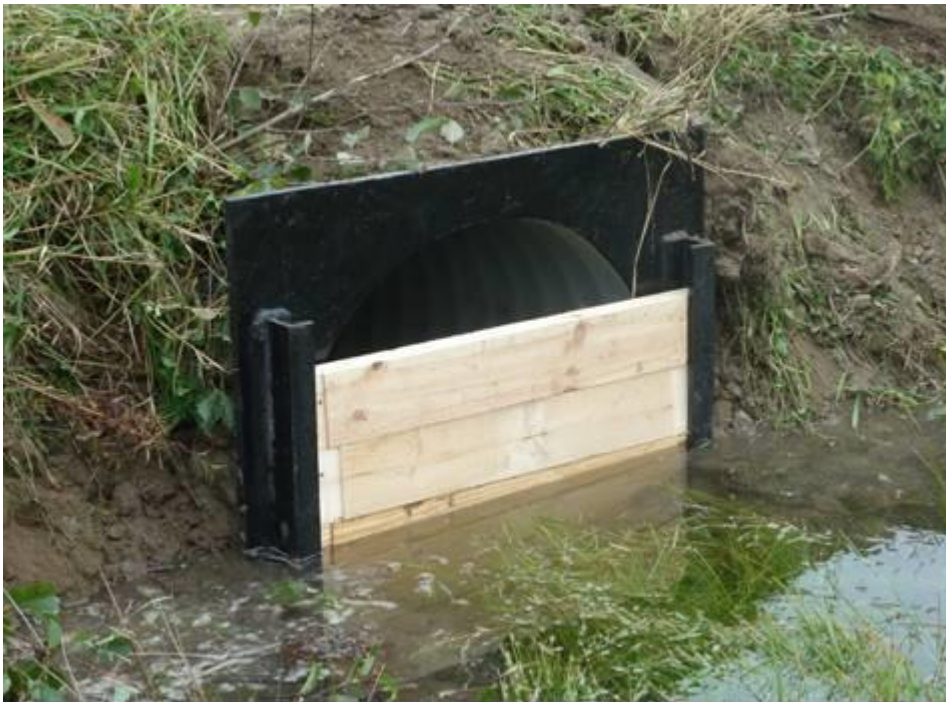
Kuva 13. Sulkuputki padotuslankuilla, lankut á 10cm. Mallikuva.
