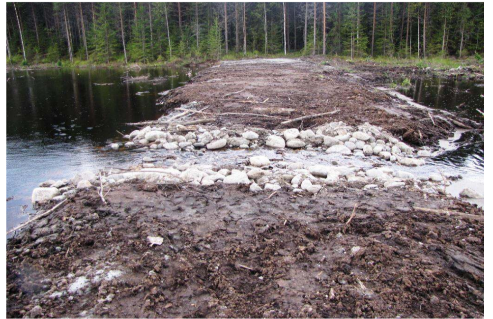
Kotousslampien kosteikolle rakennettiin kolme patopengertä, jotta alueelle saatiin muodostettua mahdollisimman paljon vesilintujen suosimaa matalaa vesialuetta. Kuva Reijo Kotilainen 15.8.2012
