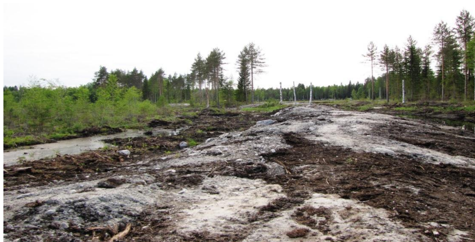
Kosteikon ympärille rakennettiin kaivumaista suojavallit. Kuva Reijo Kotilainen 5.6.2013.
