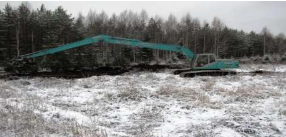
Kosteikon kaivamisessa käytettiin leveätelaista ja pitkäpuomista kaivinkonetta sen kantavuuden ja ulottuvuuden ansiosta. Kuva Reijo Kotilainen 3.1.2012
