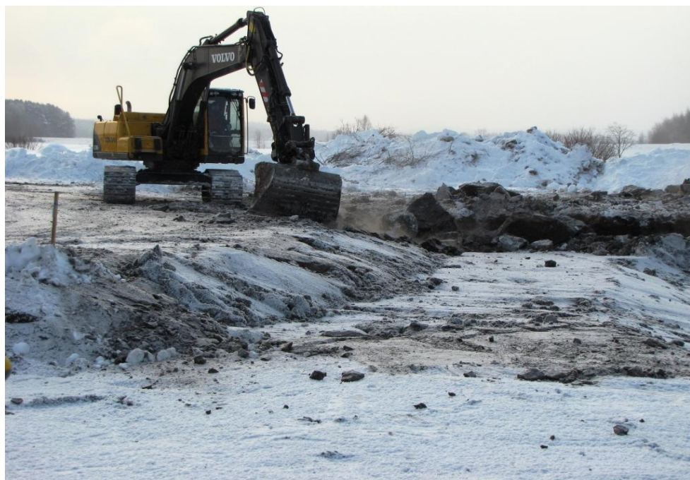
Pakkastalvesta johtuen jäädyttäminen onnistui turhankin hyvin, mikä asetti haasteita kaivutyölle ja kalustolle. Kuva Reijo Kotilainen 25.2.2011
