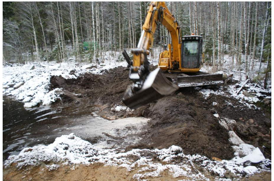
Padon kriittisin kohta, vanha uoma tiivistettiin korjauksen yhteydessä huolella. Kuva: Jouni Tolvanen, marraskuu 2012.
