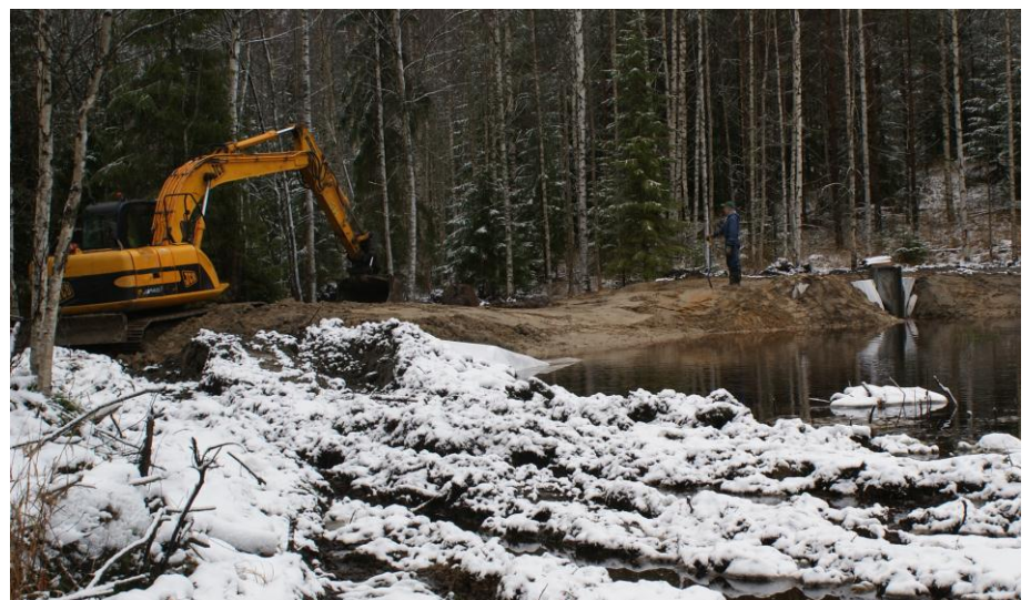
Tulvakynnys tehtiin vanhan uoman kohdalle ja kivettiin seuraavana kesänä. Käytettävissä ollut maa-aines oli hyvin hienojakoista, joten patopenkkaa vahvistettiin maanrakennuskankaalla. Kuva: Jouni Tolvanen, marraskuu 2012.
