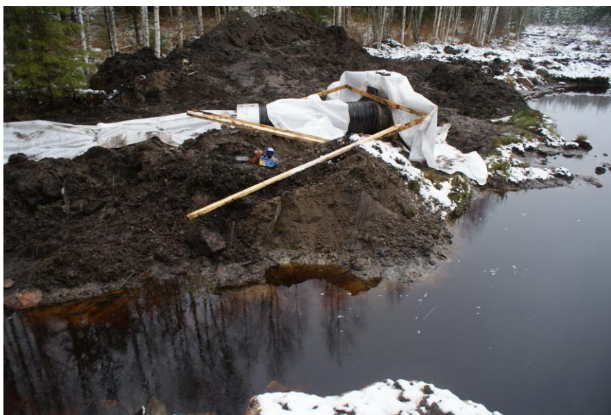
Säätelylaitteen paikka jouduttiin siirtämään korjauksen yhteydessä vanhan uoman viereen, jotta asennus voitiin tehdä kuivatyönä. Paikan muutoksen takia jouduttiin rumpuputkea jatkamaan. Kuva: Jouni Tolvanen, marraskuu 2012.
