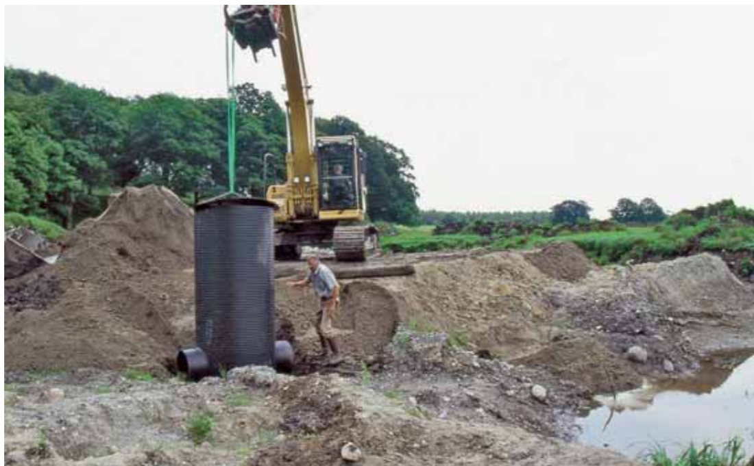
Ns. munkin sijoittaminen patoon on varsinkin isommissa hankkeissa käytännöllinen ja kestävä ratkaisu veden säätelyä varten.
