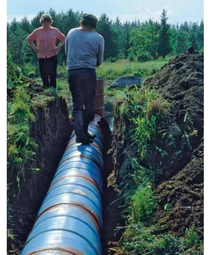
Riistakosteikon vedennoston yhteydessä on hyvä varmistaa mahdollisuus kosteikon kuivattamiseen. Munkin johtoputki tai korkeudeltaan säädeltävä kuivatusputki suunnitellaan riittävän syväälle.
